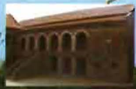
7. Centre socio-culturel et théâtre en plein air (construit en 1777, tombé en ruines, réhabilité en 2005)
